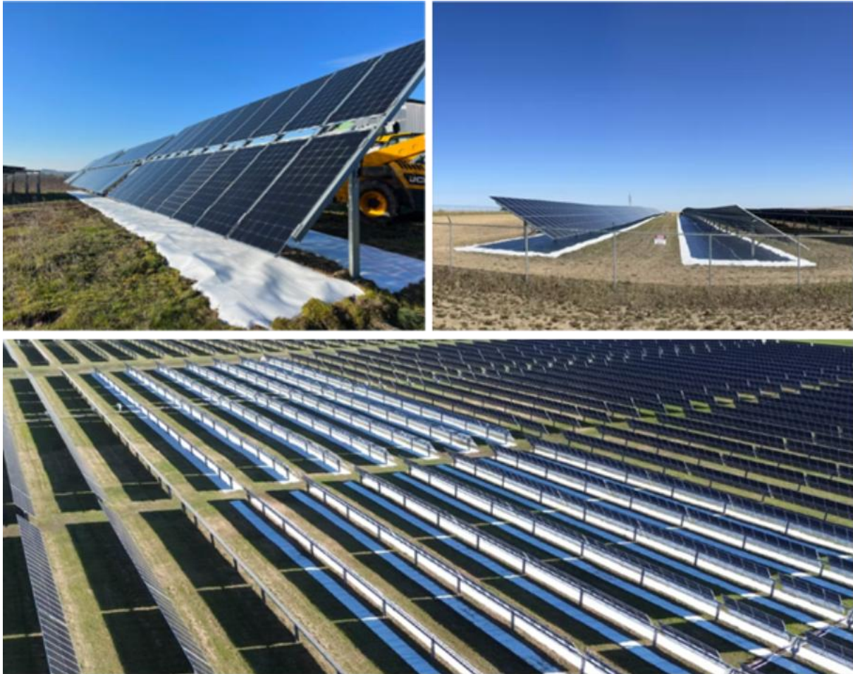
Figur 9. Exempel på hur geotextil kan se ut i en solpark. Notera att bilderna inte är från Alights egna projekt. Bildkälla: Geolux solutions.
