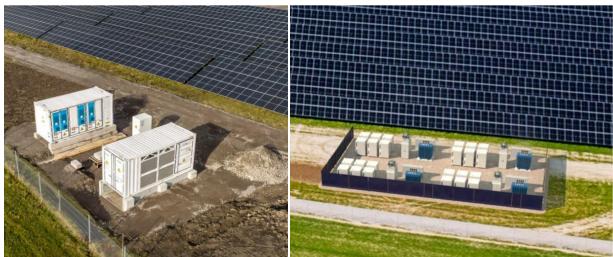
Figur 6. Batterilager, container-baserad lösning (vänster) och utomhusskåplösning (höger).
