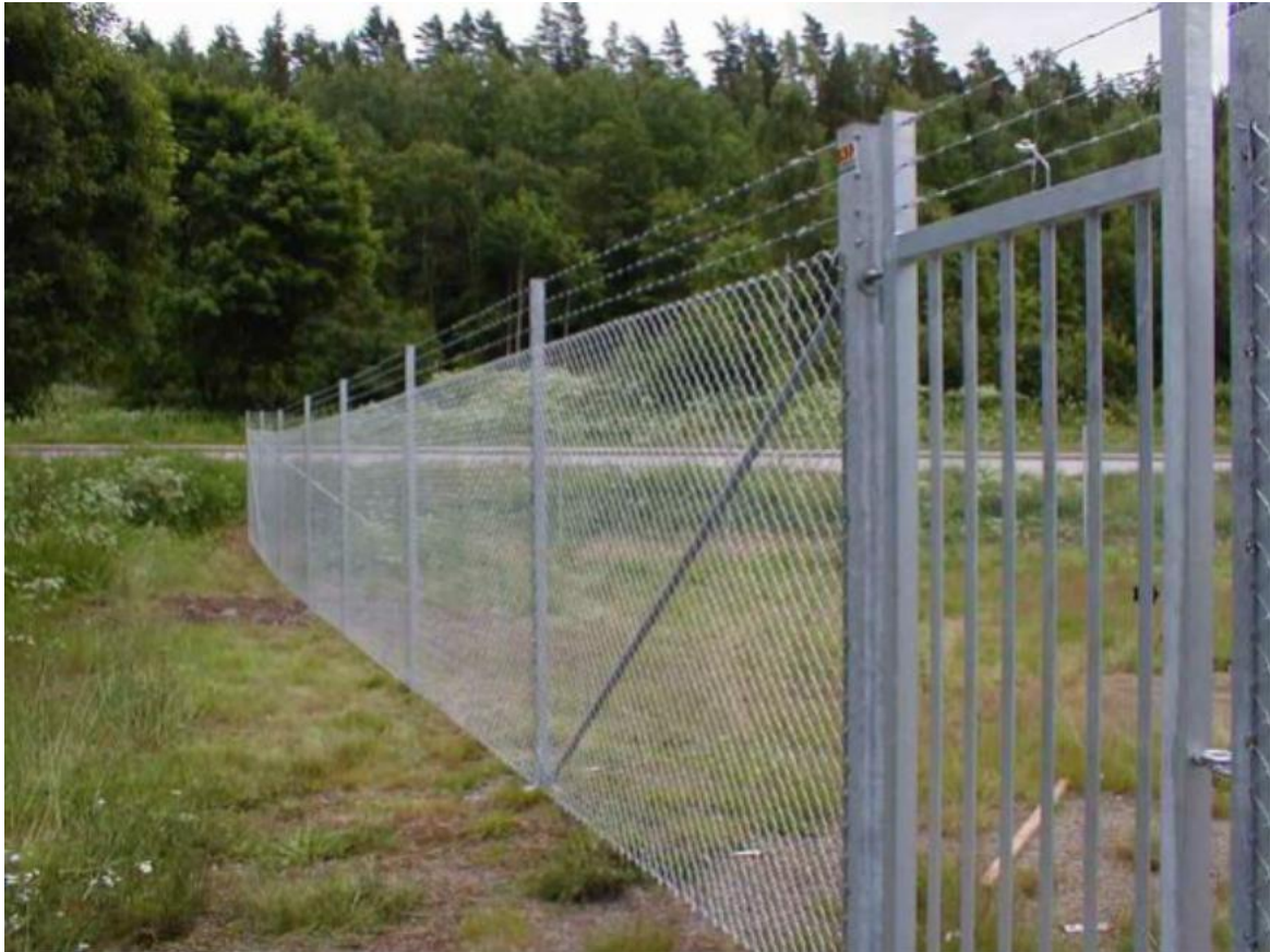
Figur 8. Industristängsel, ca 2,45 m högt.
